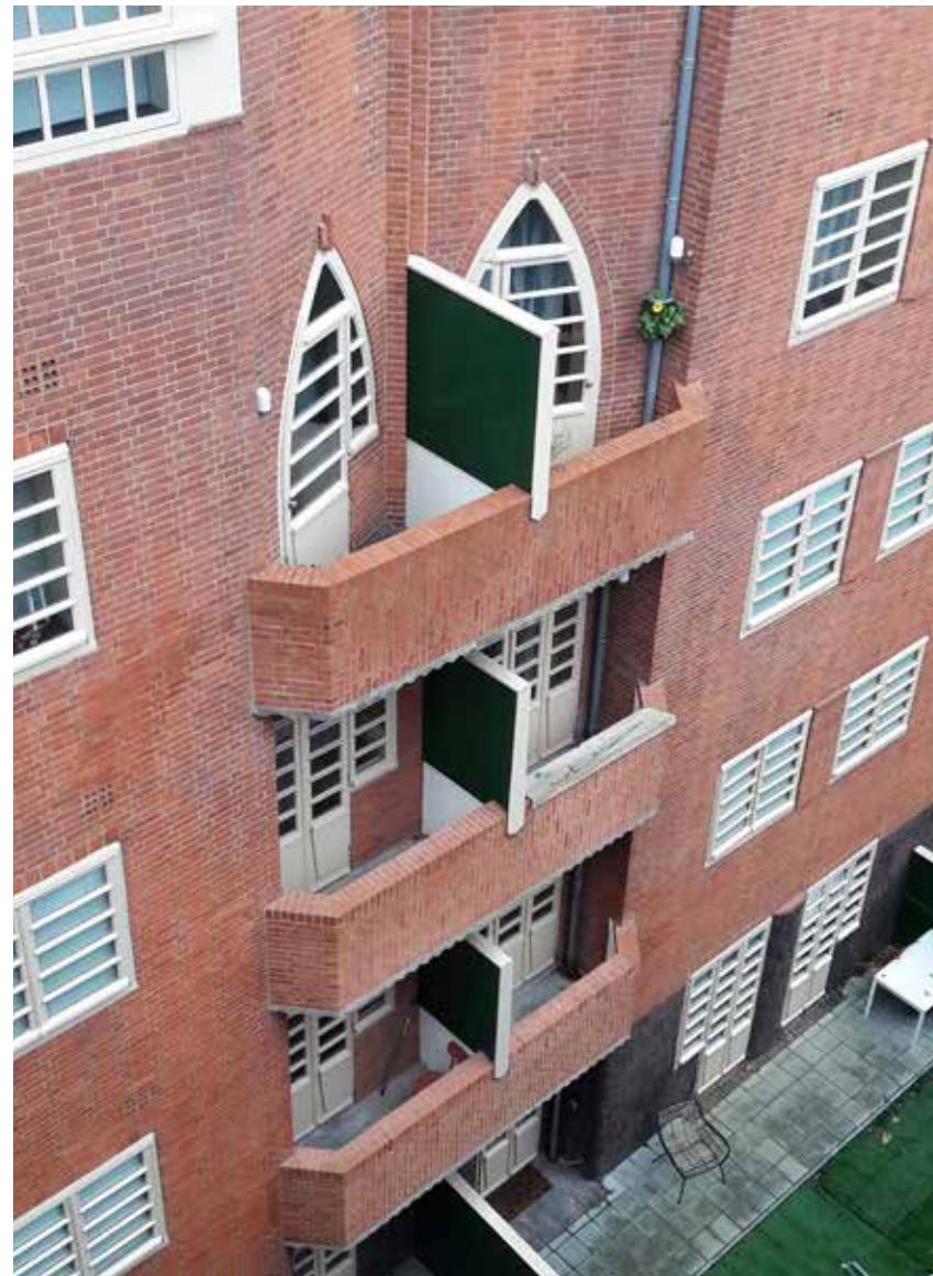
De achtergevel. In totaal zijn 150.000 tot 160.000 bakstenen vervangen.
