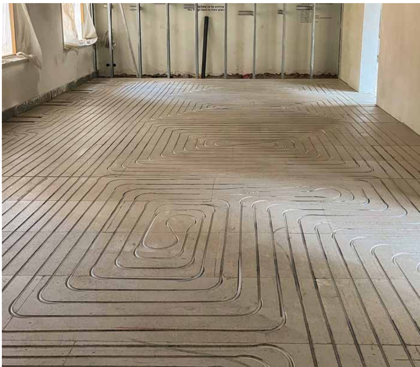
De vloerverwarming is ingeslepen in de vloer.
