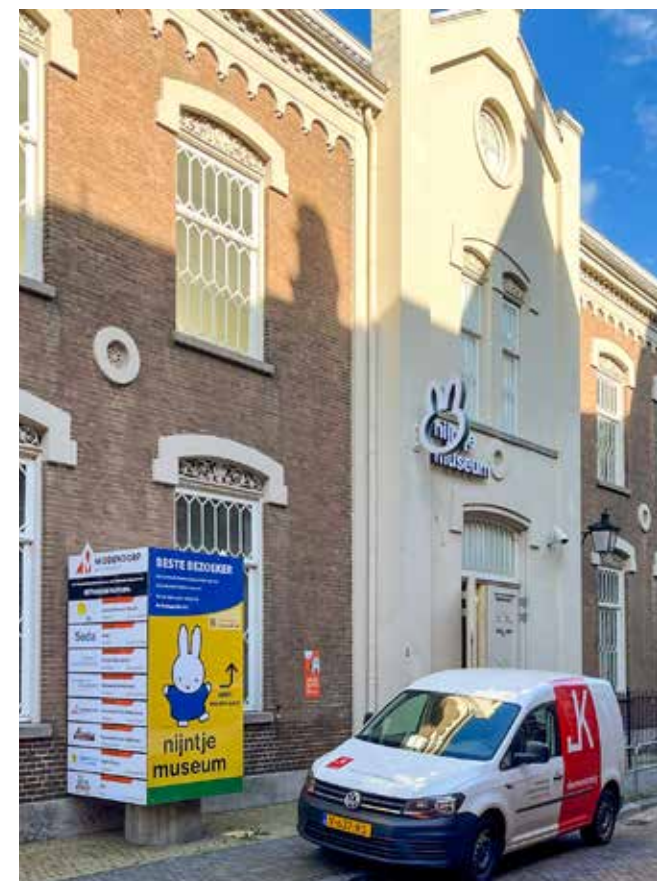
Een mooi projectvoorbeeld is de verbouwing van het Nijntje Museum in Utrecht.
