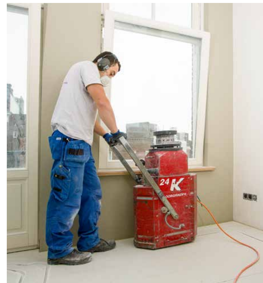
Door gebruik te maken van een speciale diamantslijpschijf, vacuümturbines en een HEPA-filter kan JK vloerverwarming volledig stofvrij strakke sleufpatronen slijpen.
