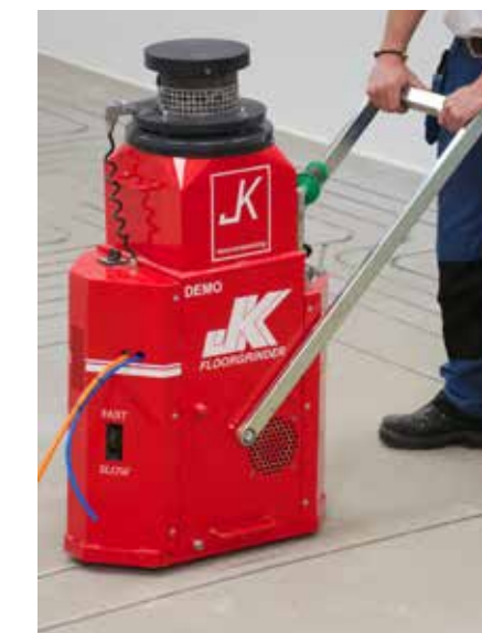
Inslijpen van de vloerverwarming met de JK floorgrinder.
